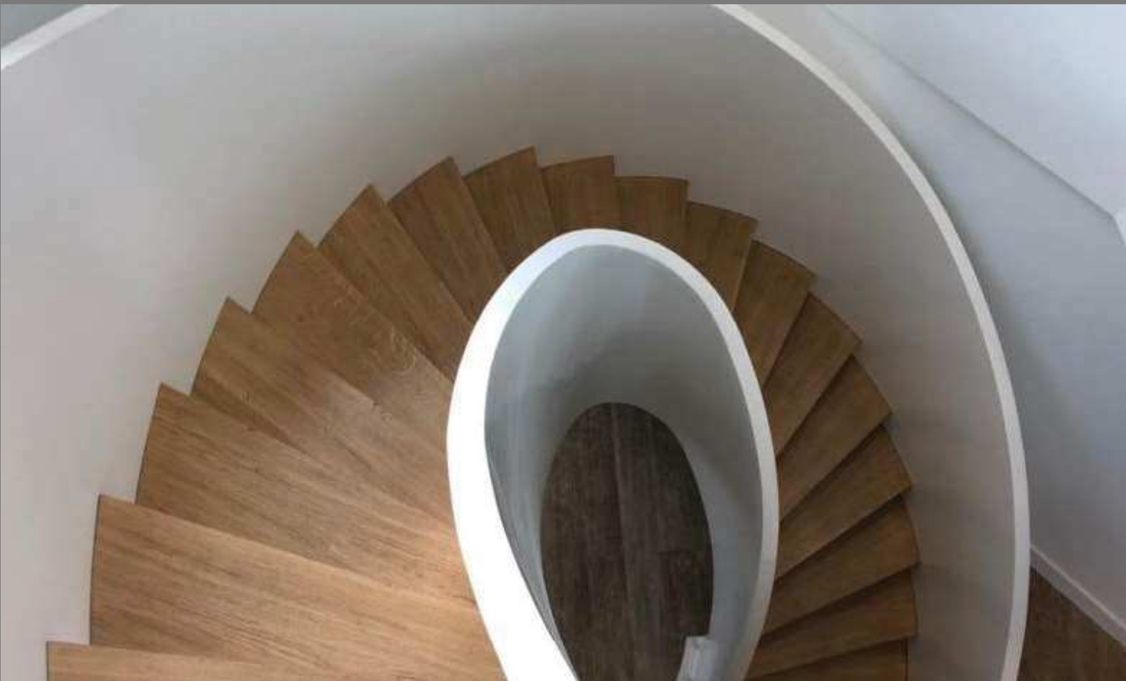
Escalier débillardé, structure acier - Finition bois
