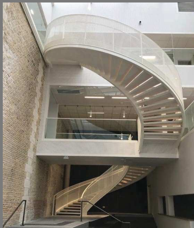
Escalier débillardé monumental
